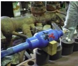
**Descripción de la técnica:** El desarme de la bulonería consiste en calentar cada perno insertando en su orificio interno un inductor especialmente diseñado de modo que el mismo caliente solamente la zona que debe estirarse. Luego de unos minutos se verifica la correcta liberación de la tensión y se procede a retirar la tuerca manualmente, tarea que se realiza con seguridad porque la tuerca está fría y sin esfuerzos físicos ya que no se requiere utilizar mazas de golpe.
